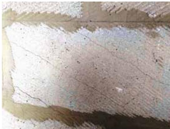
**Причини тріщиноутворення в ніздрюватих бетонних виробах:** рецептура самого бетону, порушення технології виготовлення виробів чи влаштування стіни, недостатня жорсткість несучих конструкцій, вплив критичних умов експлуатації конструкції.
