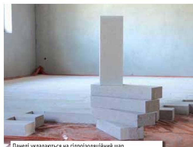
Панелі укладаються на гідроізоляційний шар, далі виконується стяжка і декоративне фінішне покриття
